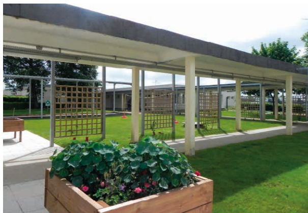
Centre de proximité - Site d'Allonnes
